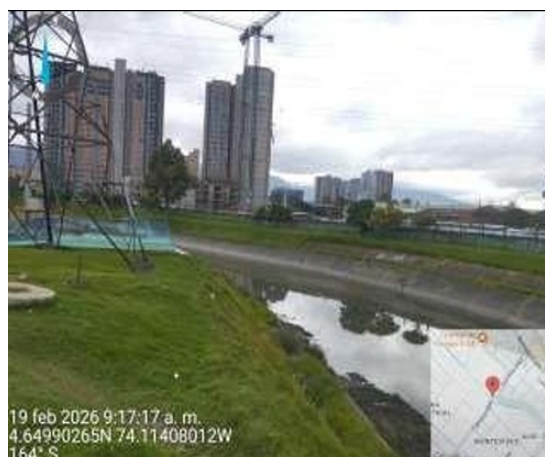
Fotografía No. 2. Vista lateral flujo de cauce canal San Francisco.
