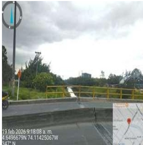
Fotografía No. 6. Vista frontal flujo de cauce canal San Francisco aguas abajo
