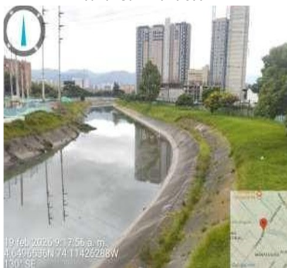
Fotografía No. 4. Vista lateral flujo de cauce canal San Francisco y, polisombra separando el acceso al canal.
